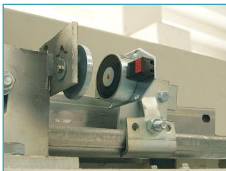
STAFFA CON ELETTROMAGNETE
